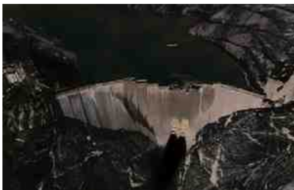
شکل ۷- سد کارون (۴) - خوزستان
